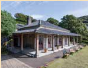
国指定重要文化財 所在地／長崎市南山手町2番地 建築年／1868年(明治元)頃 建築面積／350.8㎡ 構造／木造及び石造、平屋建、寄棟造桧瓦葺
