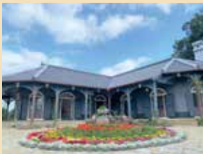
国指定重要文化財 所在地／長崎市南山手町3番地 建築年／1863年(文久3) 建築面積／510.8㎡(主屋)、129.2㎡(附属庫) 構造／木造平屋建、寄棟造、桧瓦葺、ベランダ付
