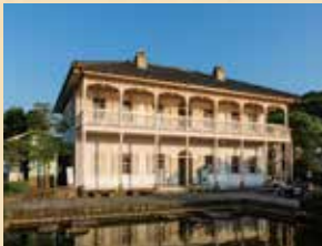
旧所在地／長崎市飽の浦町 建築年／1896年(明治29) 移築年／1972年(昭和47) 建築面積／201㎡ 構造／木造、2階建 旧所有者／三菱重工業株式会社
