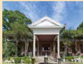
保存修理工事 期間:2022.12.1～2025.11(予定) 国指定重要文化財 所在地／長崎市南山手町14番地 建築年／1865年(慶応元)頃 建築面積／504.1㎡ 構造／木造及び石造、平屋建、正面寄附付、寄棟造桧瓦葺
